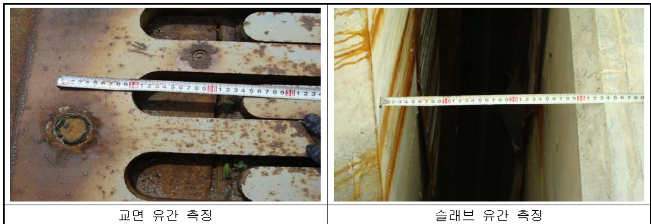
【사진 3.8】 유간 측정 현황
